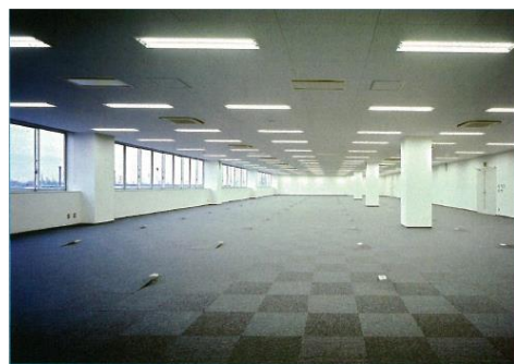
事務所棟内部 フリーアクセス
