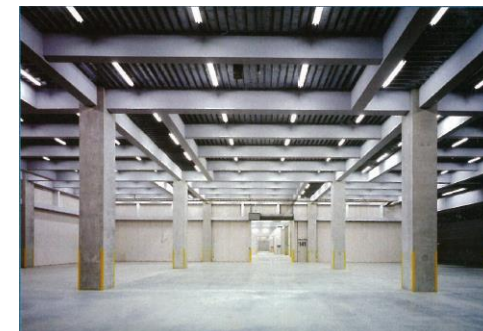
倉庫内部 各階6,300坪 (倉庫・荷捌部分)
