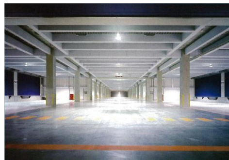
1F 車路 全天候型倉庫
