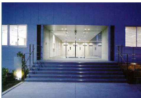
事務所棟 玄関 24時間操業可能
