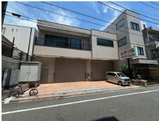
● 第5MTビル現地写真
