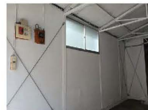
西面: 高窓と電気メーター
