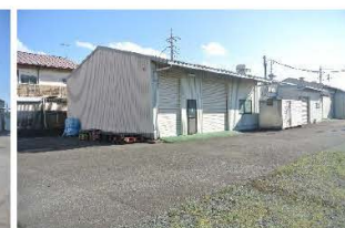
②工場外観
