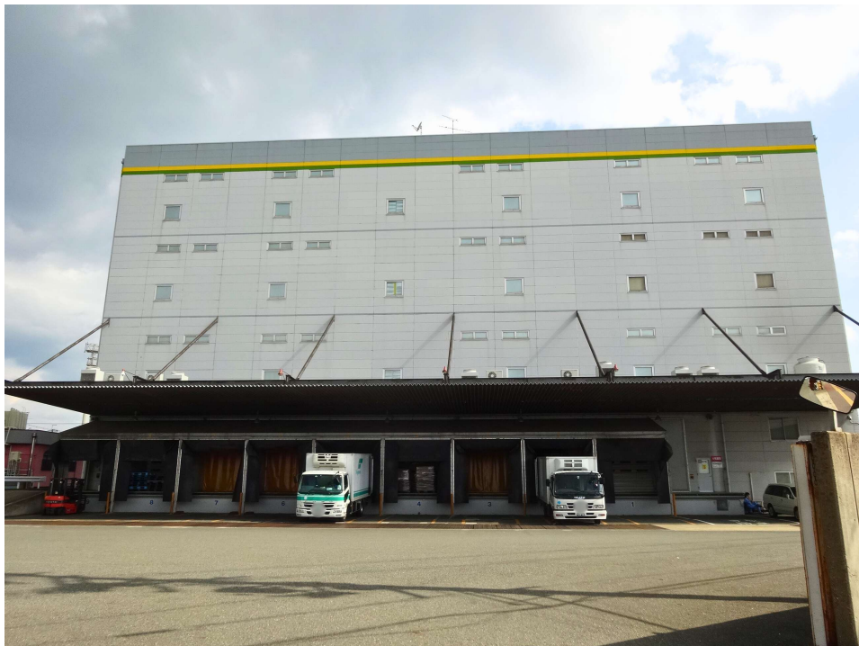
高床式プラットホーム
