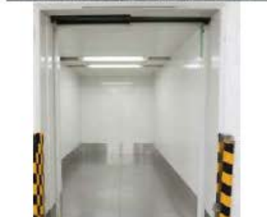
貨物用EV（1階～8階本床各フロア停止） 奥行：約2.8m高さ：約2.1m 横幅：約2.2m
