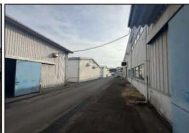
B棟(右)C棟(左手前)D棟(左奥)通路部分
