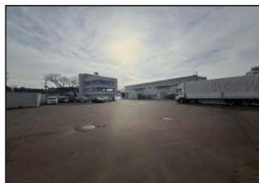
駐車場(左)事務所(中央)外観
