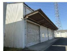
倉庫・作業所1（約330m 2 ・H5築）
