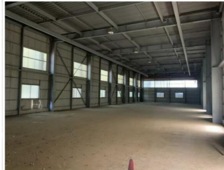
A 物件 内部
